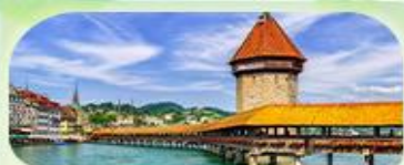
สะพานไมซ์าเปลา
